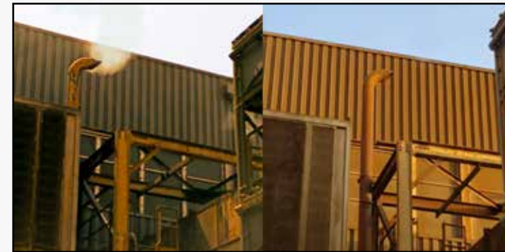
Vorher-/Nachher-Vergleich: Ölnebel an einer Gasturbine vor und nach der Installation eines Ölnebelabscheiders von FRANKE-Filter.
